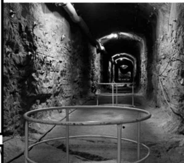
フィンランド西部エウラヨキ島にあるオルキルオト原子力発電所で 建設中の、高レベル放射性廃棄物を半永久的に地中に埋める最終 処分場(2016年4月28日撮影)。(c)AFP/Sam Kingsley
