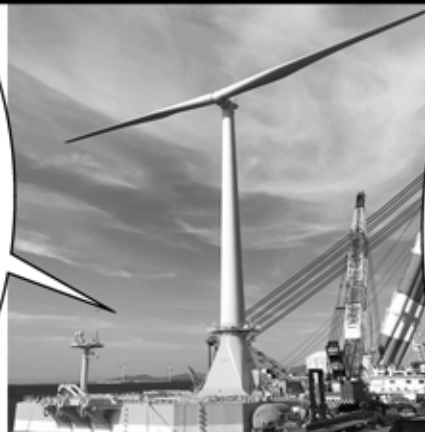
丸紅や日立造船などが共同開発した 2枚羽根の浮体式洋上風力発電 システム NEDOニュースリリース 2018年8月10日より
